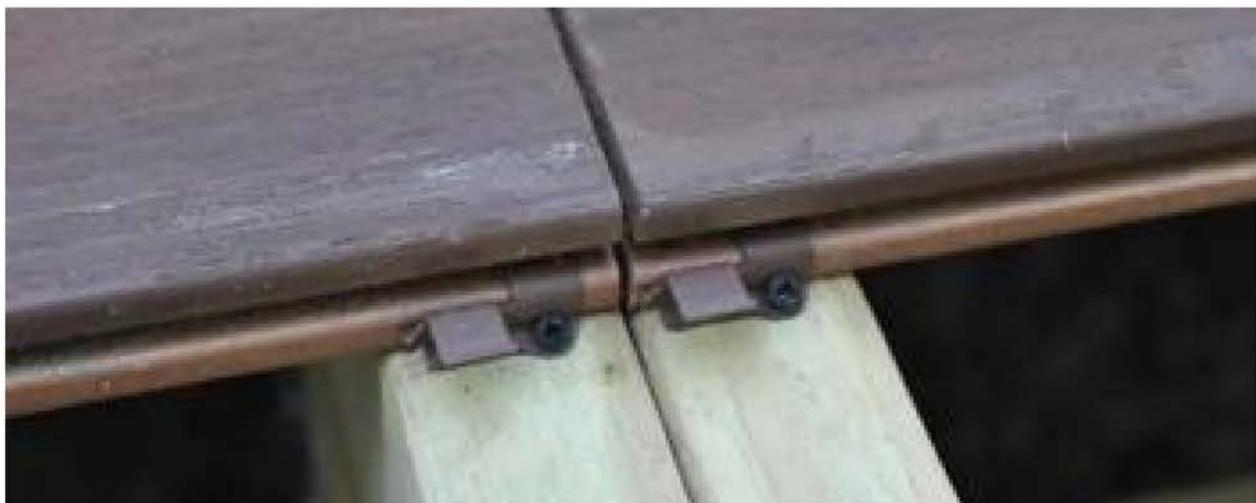
Se deben utilizar vigas dobles en las juntas longitudinales de dos tablas. La posición inicial / final de cada tabla debe fijarse con un clip.
