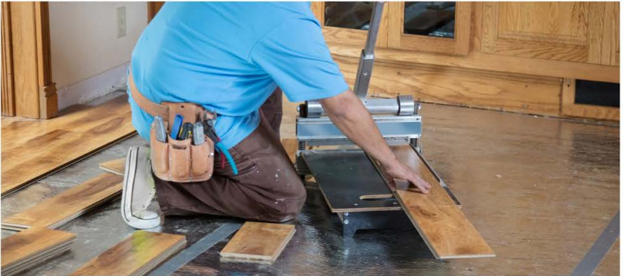
El piso de bambú con click se puede cortar fácilmente con una sierra eléctrica o/y guillotina, la parte decorativa se debe situar hacia arriba.
