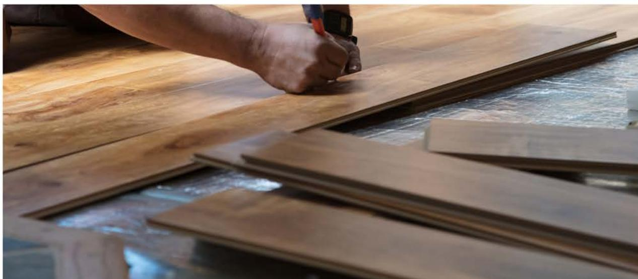
Para obtener un resultado más natural, puedes utilizar la pieza restante del final de la hilera anterior como primera pieza de una nueva hilera (siempre que esta pieza tenga una longitud de al menos 40 cm.)
