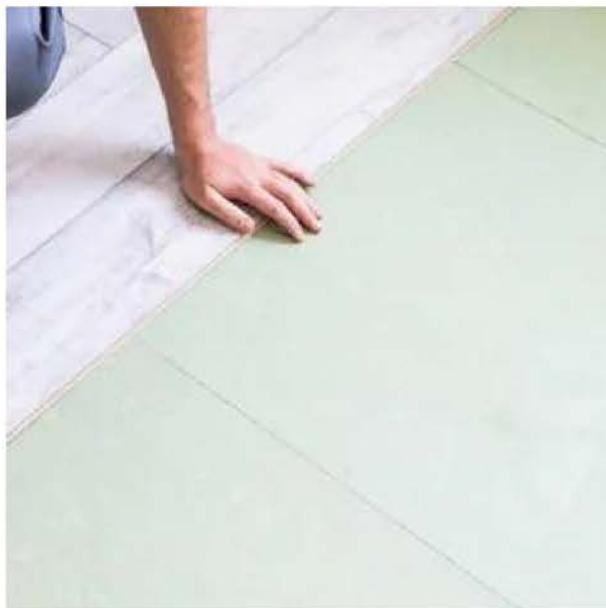
Esto es otro paso importante para la colocación de este tipo de piso, ya que este es donde será colocado el piso de bambú con click y será el protector del suelo base. Es importante que el suelo base esté libre de polvo y escombros. Verifique que no haya clavos sobresalientes y/o defectos en el subsuelo. Si se instala sobre concreto, este deberá estar seco y limpio.
