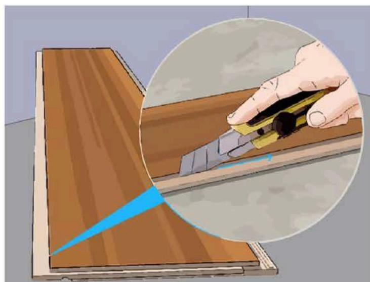
Si no necesitas recortar el ancho de la primera hilera, tendrás que cortar la lengüeta axial (elemento de conexión) que quede suelta, para obtener un borde liso y sólido contra la pared.
